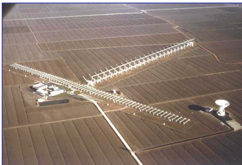
Figura 1 - veduta aerea della stazione Radioastronomica di Medicina
