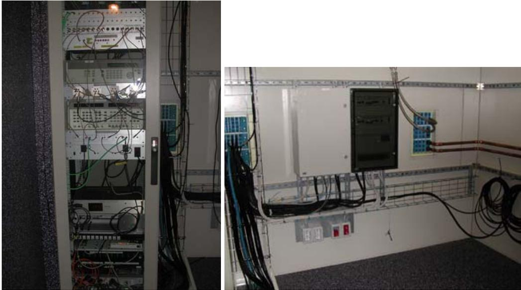
Fig. 7 Nuova sala vertex-room: rack strumenti (sinistra) e cablaggio
