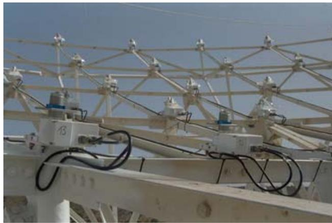
Fig. 4 Attuatori montati sulla back-up structure dell'antenna di Noto
