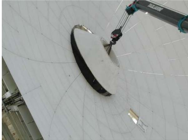
Fig. 11 Struttura originale di fuoco cassegrain, un solo foro centrale
