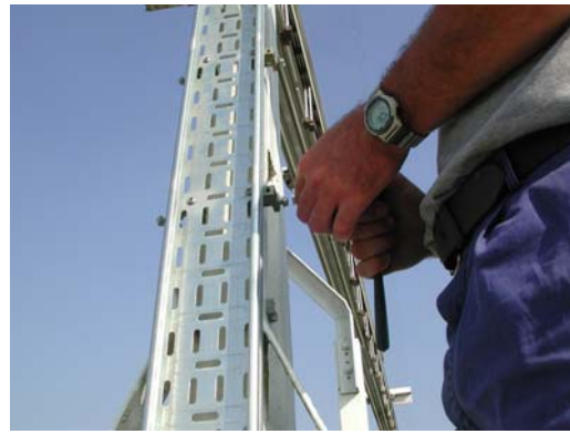
Fig.1-29 Fissaggio base rettilinea su antenna
