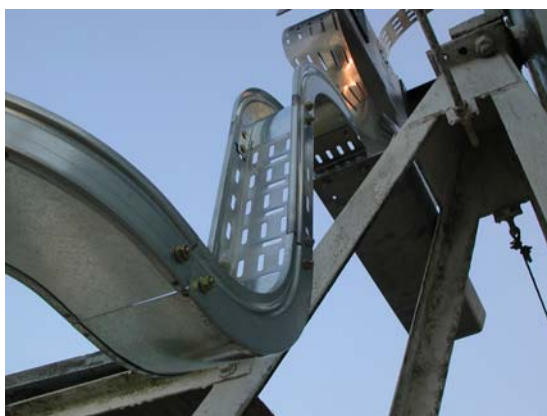
Fig.2-07 Posizionamento canalizzazione
