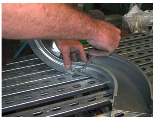
Fig.2-06 Collegamento curve
