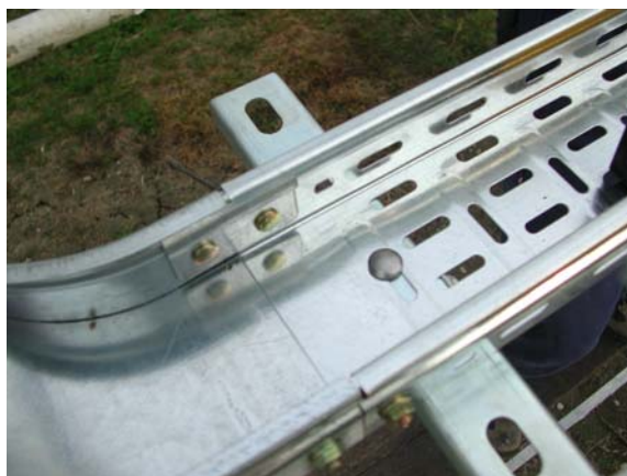
Fig.2-19 Fissaggio della canalizzazione
