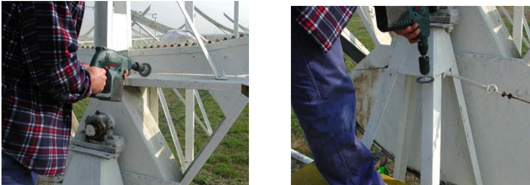
Fig.1-25 Levigatura superficie
