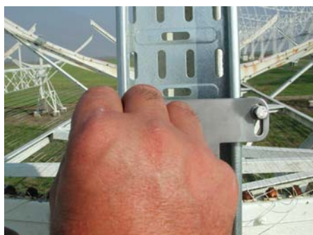
Fig.1-32 Fissaggio piastra curva inferiore su supporto
