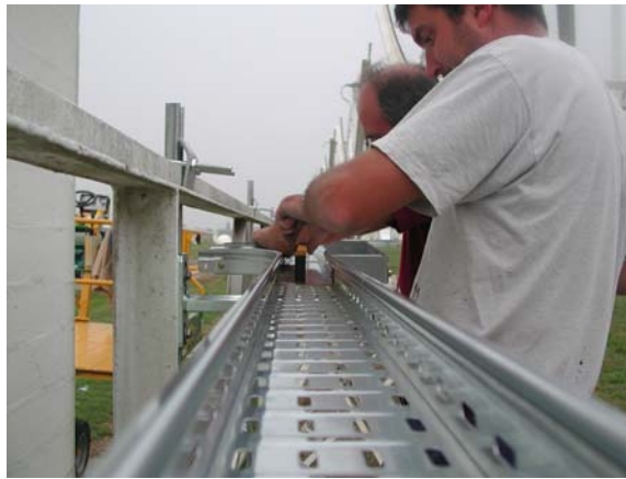
Fig.2-13 Collegamento derivazione a T
