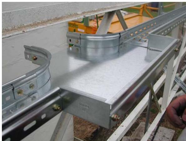
Fig.2-14 Basi rettilinee successive alla derivazione a T
