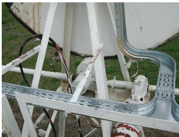
Fig.2-16 Fissaggio tra basi rettilinee
