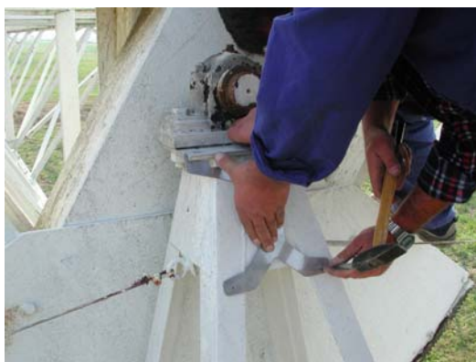
Fig.1-22 Posizionamento dima e tracciatura fori
