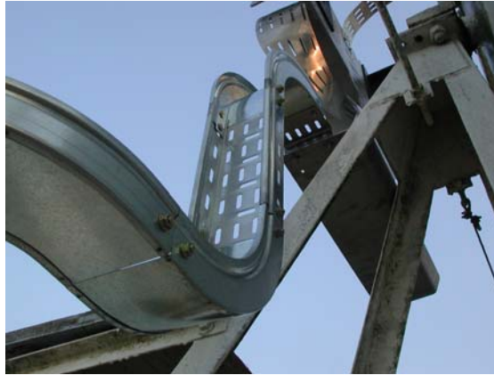
Fig.2-10 Fissaggio canalizzazione
