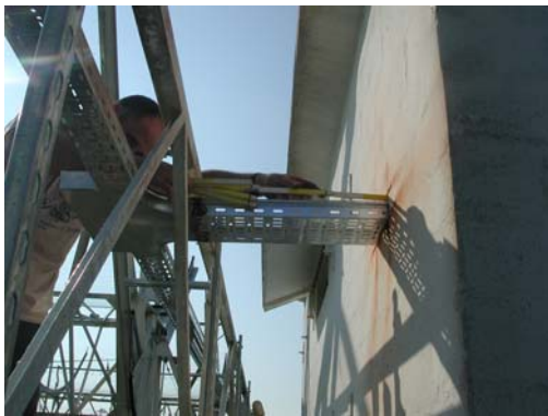
Fig.2-22 Fissaggio canala
