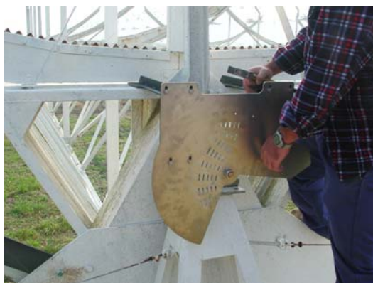
Fig.1-20 Posizionamento tamburo traccia fori
