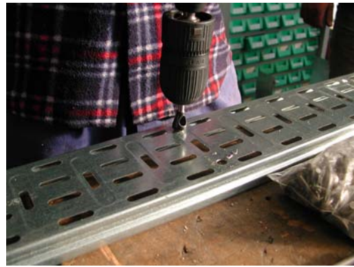
Fig.1-10 Esecuzione e svasatura fori su base rettilinea
