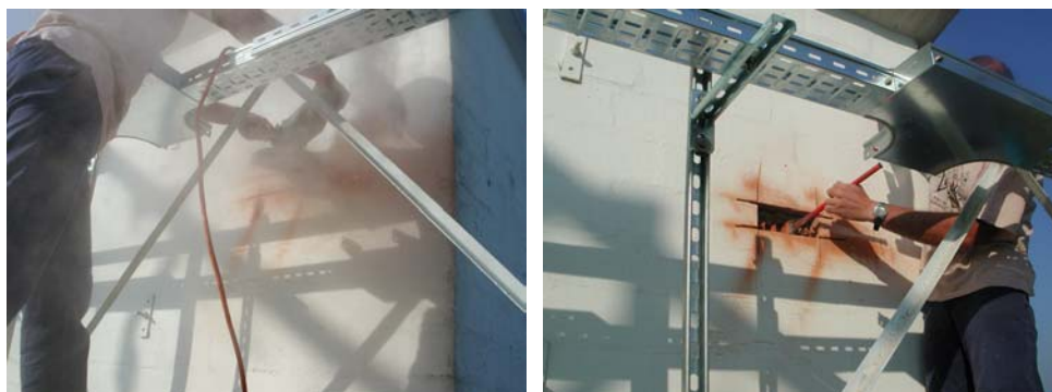
Fig.2-20 Foratura muro
