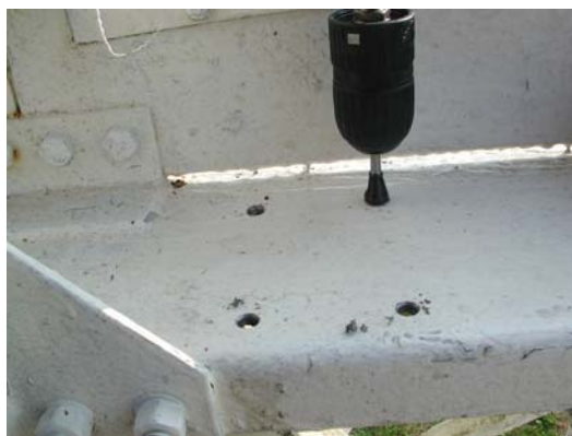
Fig.1-24 Svasatura fori
