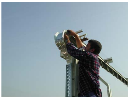
Fig.1-28 Fissaggio curva Legrand su piastra di blocco inferiore
