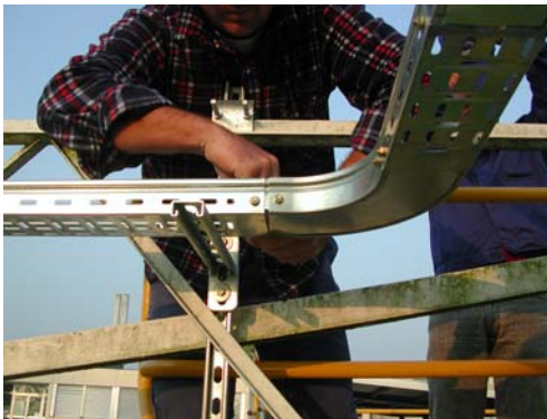
Fig.2-11 Collegamento basi rettilinee
