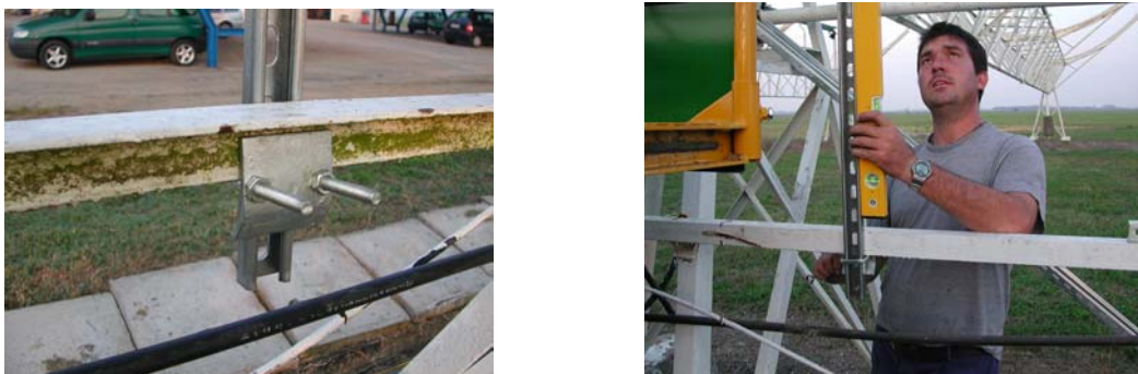
Fig.2-05 Fissaggio travi
