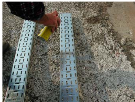
Fig.1-11 Spruzzo dello zincante
