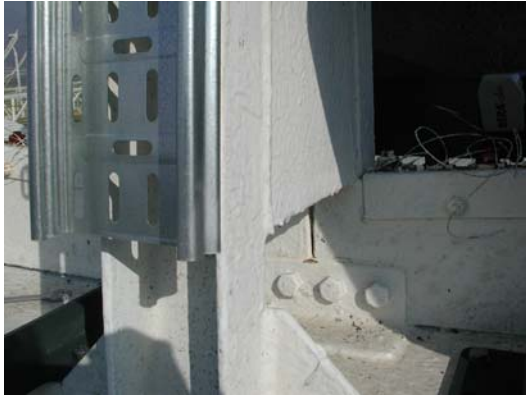
Fig.1-29 Fissaggio base rettilinea su antenna
