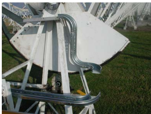
Fig.2-17 Collegamento canalizzazione
