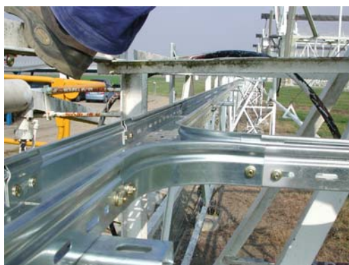
Fig.2-12 Collegamento separazione a T
