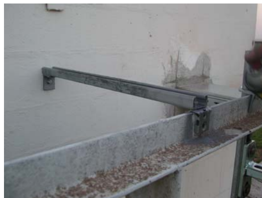
Fig.2-23 Fissaggio tirante
