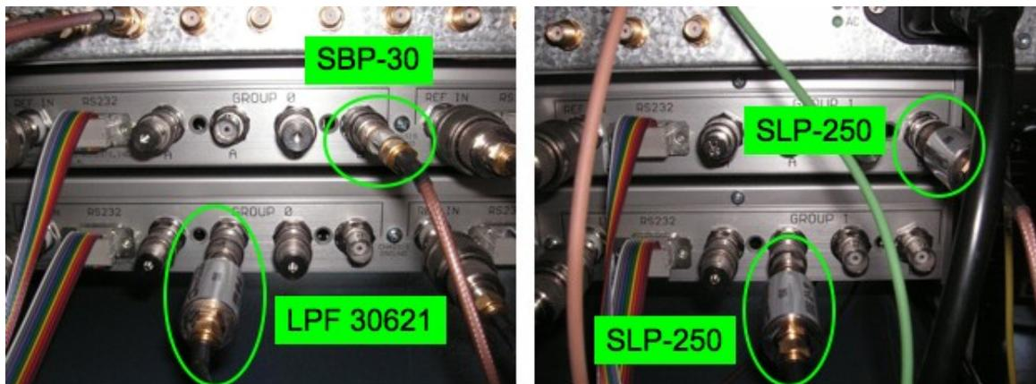
Figura 6: Banco di filtri sulle uscite dei DDS.
