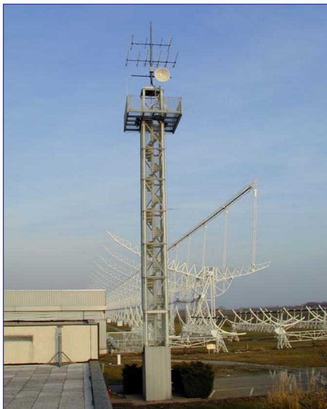
Figura 1 – la Torre RFI della stazione Radioastronomica di Medicina
