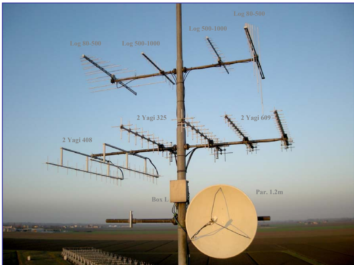
Figura 2 – il gruppo antenne della torre di Medicina
